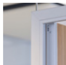
Innenliegender Schlosskasten mit Glasverklebung in schwarz oder hellgrau
